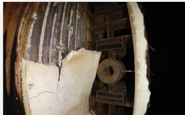
撮影したボイラー内部の破損
