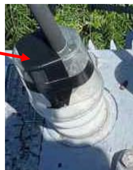
カバーの隙間を閉塞 （応急対策）
