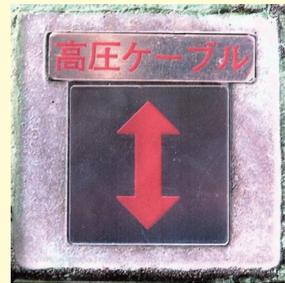
埋設地点の舗装面に高圧ケーブル埋設標識杭を設置した。
