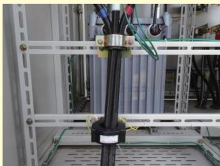
写真1 ZCTに接地線を通していない
