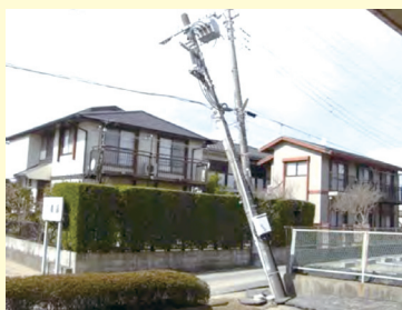
図-1 電柱倒壊
