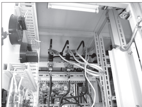
ディスコン電源側に取り付けた短絡接地器具
