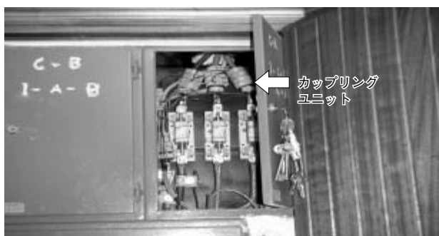
図-2 カップリングユニット(CTを用いた非接触型の場合の例)
