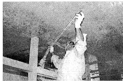
写真-1 テープケーブルの天井取付け
