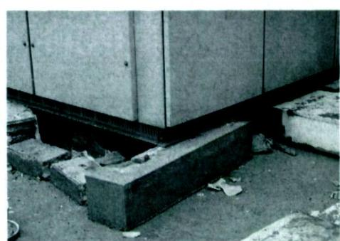
基礎破損によるキュービクルの移動
